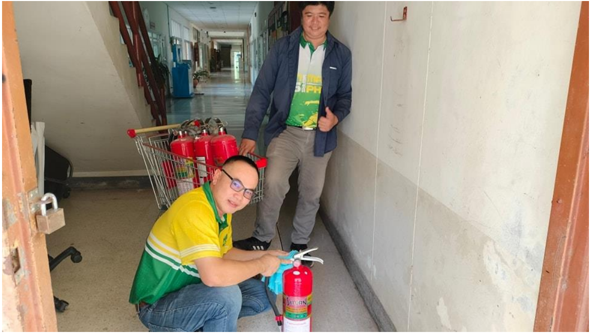
ภาพ การตรวจถังดับเพลิง
